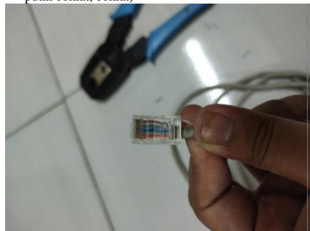
Gambar 6. Tampilan Pemasangan konektor RJ-45
